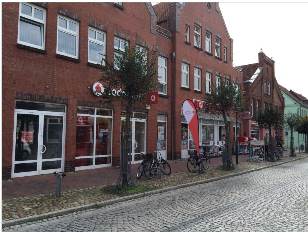
Abbildung 14: Lange Straße, ZVB Innenstadt Hagenow
